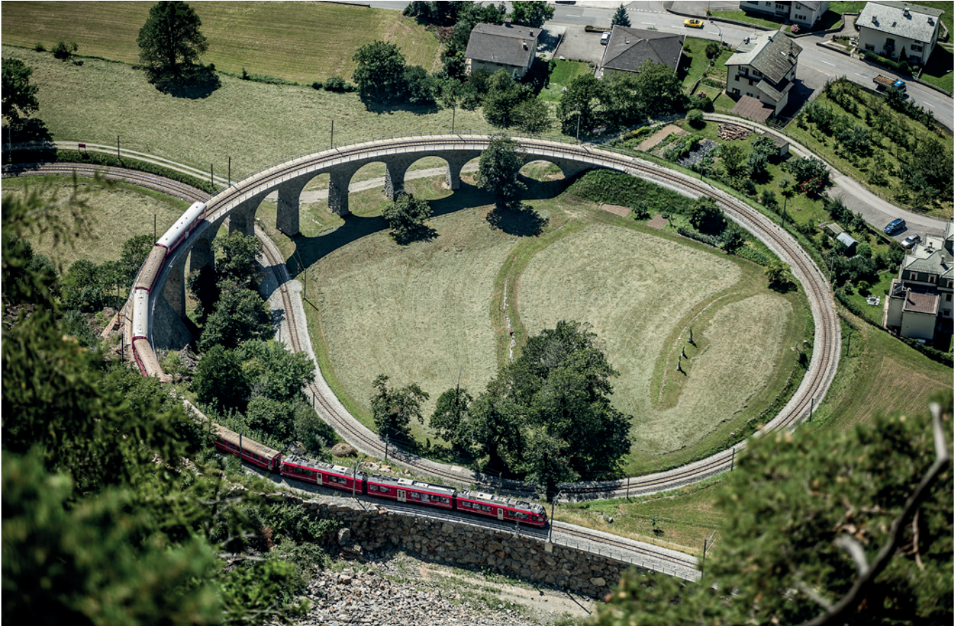
19. Chemins de fer rhétiques – viaduc hélicoïdal de Brusio
